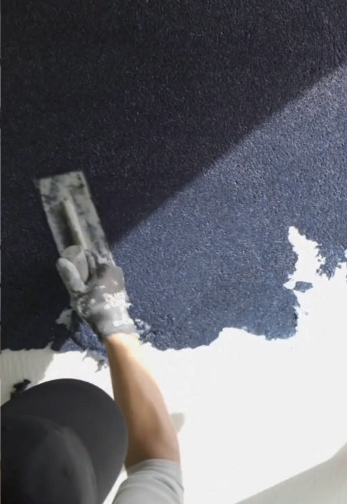
インディゴブルー施工例 (アートチャイルドケア岡山早島児童プラザ)
